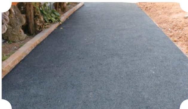
道路系统维修后
