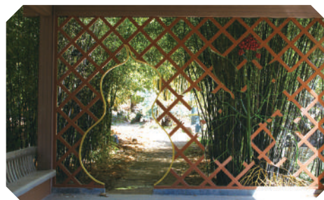
休息廊维修后2
