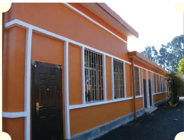
工作间外立面维修后
