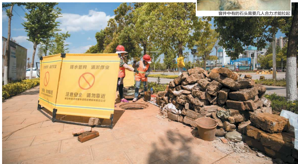
昌宏西路一段约 2.5 公里长的排水管道里填满了砖块、石头等建筑垃圾,排水公司出动多名工作人员进行清理
